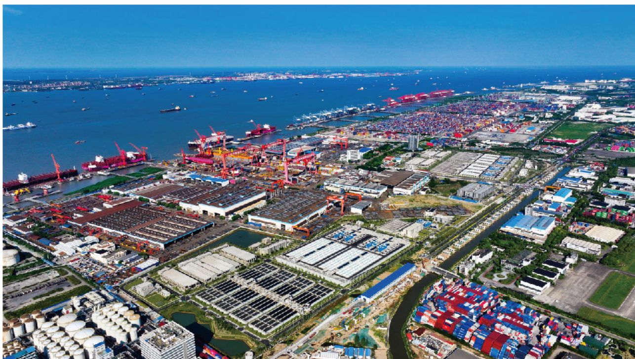
竹园污水处理厂四期工程
